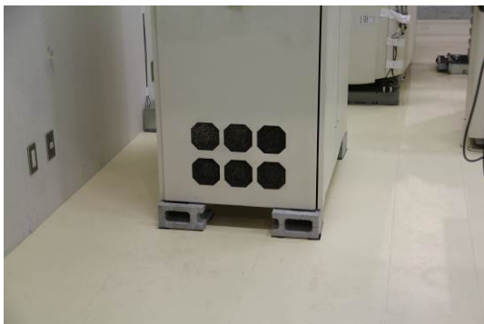
CT 電源 固定
