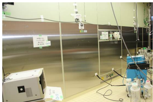
壁面衝突対策 ステンレスプレート 対策状況
