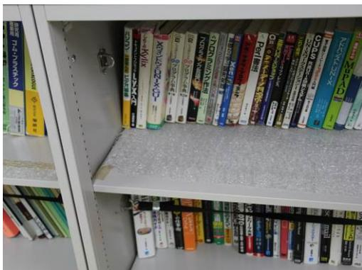
図 22 バンド、落下防止シート設置
