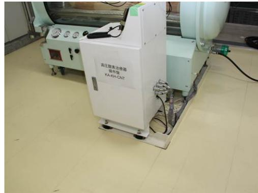
図 65 床上フレームへの固定
