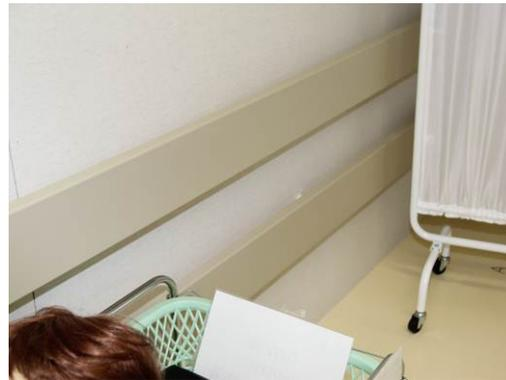
図 74 手すり衝突ガード等による機器衝突対策
