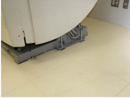
図 62 床にアンカー固定
