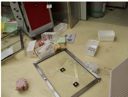
図 36 薬品棚の扉・棚板が脱落
