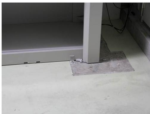
図 81 重量物のアンカー固定
