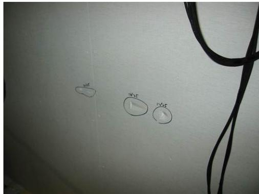
図 68 機器の衝突による壁の破損
