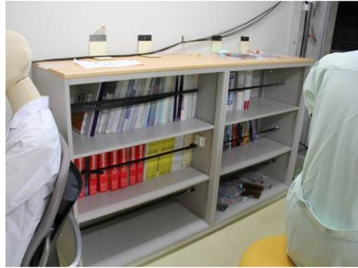
図 21 落下防止バンド、シート設置
