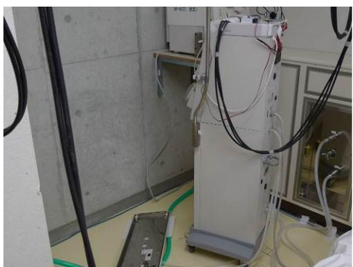
図 48 透析装置の移動，部品脱落
