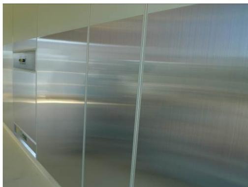
図 103 壁保護板（ステンレス版等）の設置
