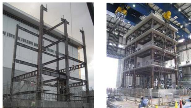
(b) 屋外での骨組製作 (d) 振動台への設置と組立
