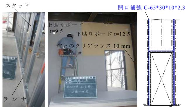
図 25 軽鉄下地間仕切壁の設置状況
