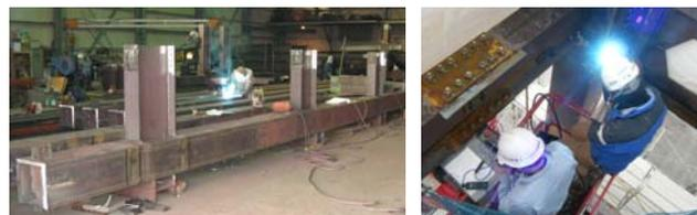
(a) 工場での柱梁接合部溶接 (c) 屋外での現場溶接
