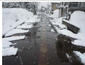
消雪パイプ稼働中の道路 (地下水を散水し消雪)
