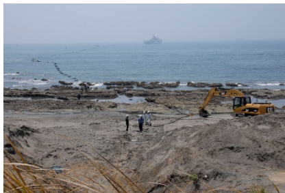
写真1 ケーブル陸揚げの様子
