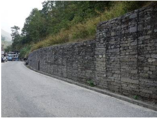
写真-2 蛇籠道路擁壁
