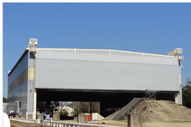
写真 1 大型降雨実験施設全景
