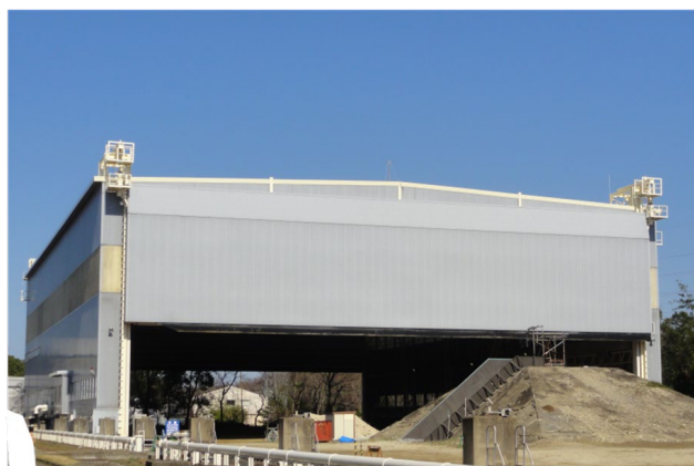
写真 1 大型降雨実験施設全景
