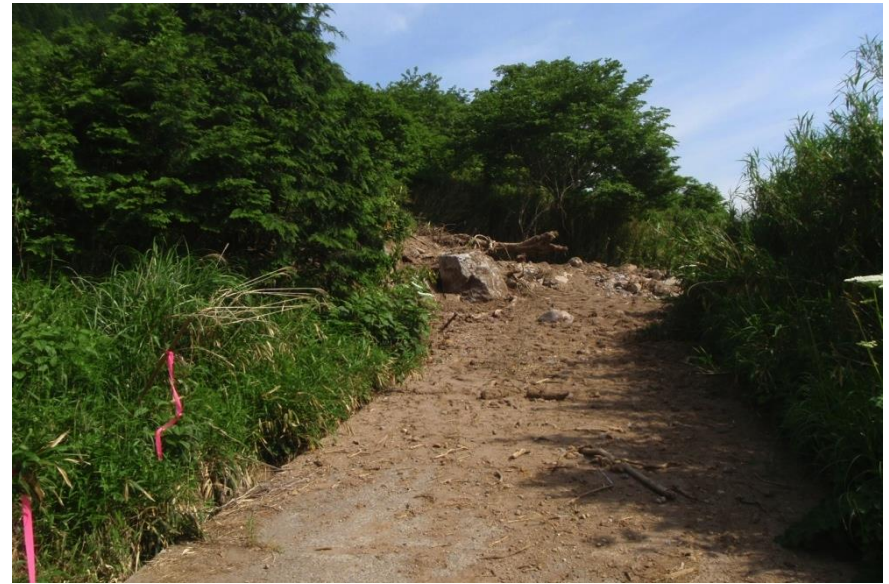
土石流によって閉塞された道路（5月21日撮影）
