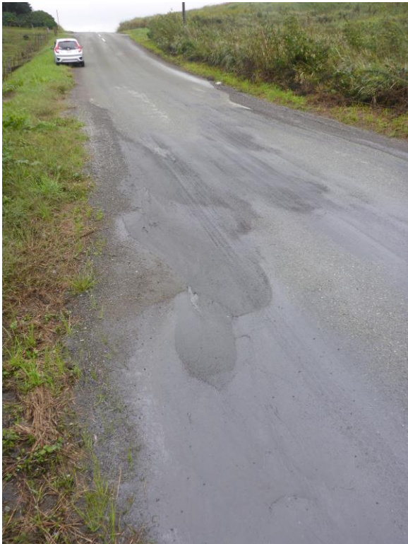
図10:火口から北東に約13km離れたミルクロードの状況。細粒な火山灰は降雨で移動し窪地などに集まって残存している。
