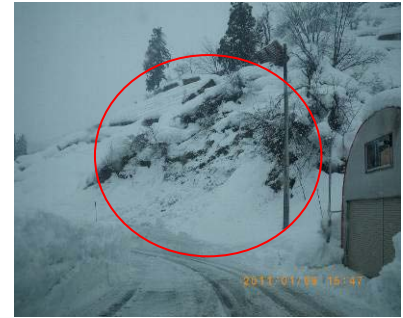
図1 雪崩発生状況(長岡市南平)
