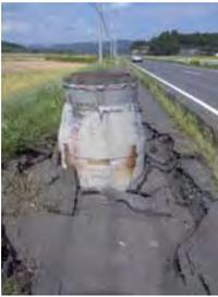
丸ピンがマンホールです。ペットボトルをさかさにして砂を静かに沈めると、丸ピンは砂の中。これが地震の来る前です。このボトルをデコピンすると砂の中に埋まっていた丸ピンが浮かんできます。デコピンが地震で、ペットボトルの中で液状化現象えきじょうかげんしょうが起きたのです。
