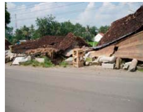
崩壊した道路脇の民家(インドネシア気象物理庁提供)
