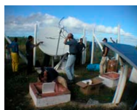
フィジーにおける地震観測点建設
