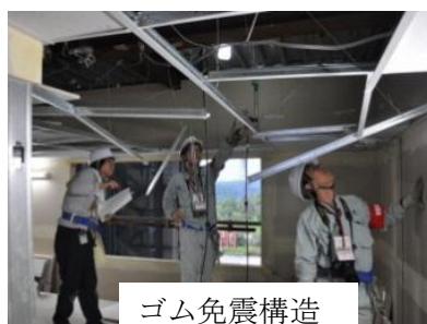
リナルディ記録による5階天井の被害
