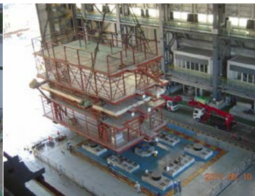
試験体の震動台への吊り込み
