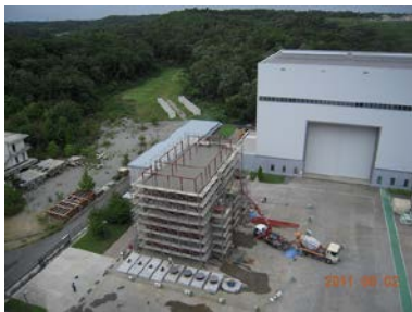
試験体施工状況
