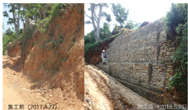
【写真5 試験施工でできた蛇籠擁壁 (JICA 事業)】
