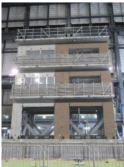
【写真1 試験体全景】
