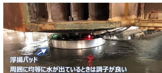
【写真 14 水を噴出する浮揚パッド（正常時）】
