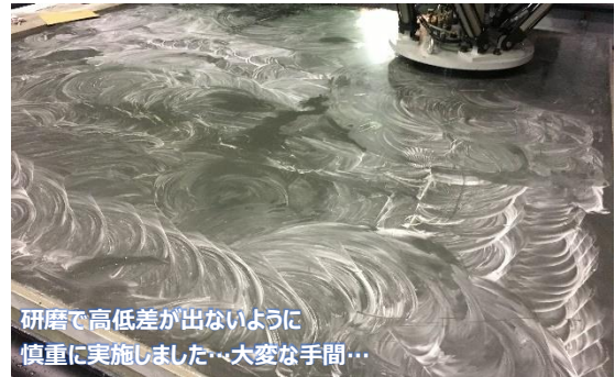
【写真9 ベース表面の研磨の状況】
