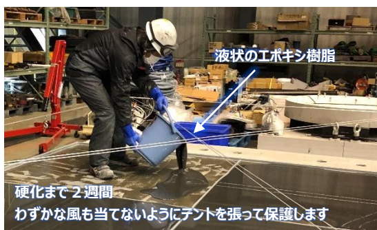
【写真5 エポキシ樹脂コーティング作業】
