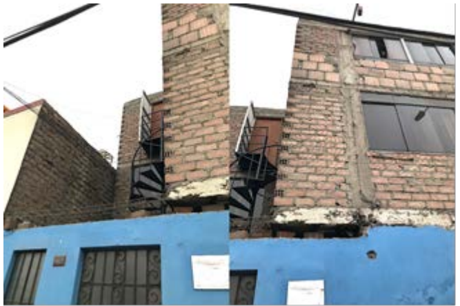
写真4 補強されていない枠組み組積造建物
