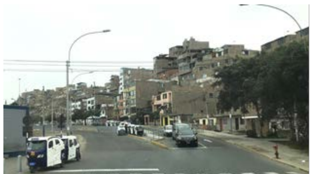
写真3 枠組み組積造建物群
