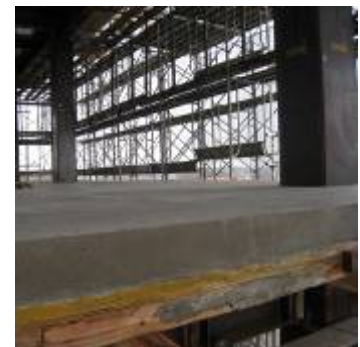
コンクリート床スラブ
