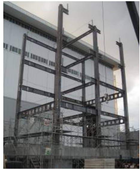
鉄骨造架構の建て方
