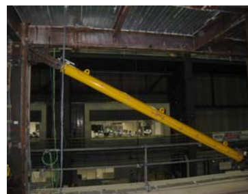
骨組内の鋼製ブレースダンパー
