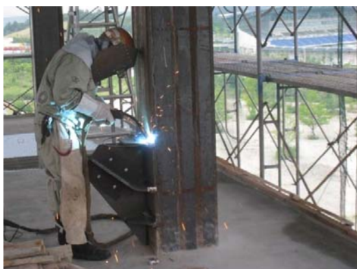
(a)制振ダンパー取り付け部の現場溶接
