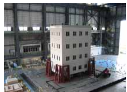
移設後の試験体(上) 移動中の試験体(左)
