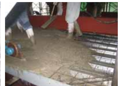
床コンクリート打設
