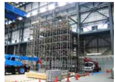
外部足場設置
