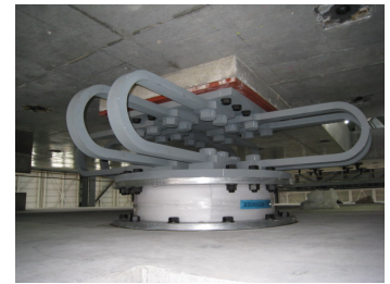
縮約層の塑性化装置
