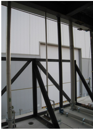
給排水立管および枝管
