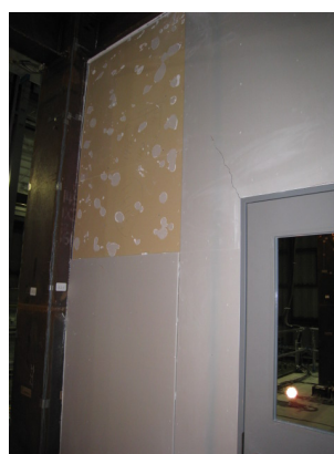
図-9 内装材の剥離
