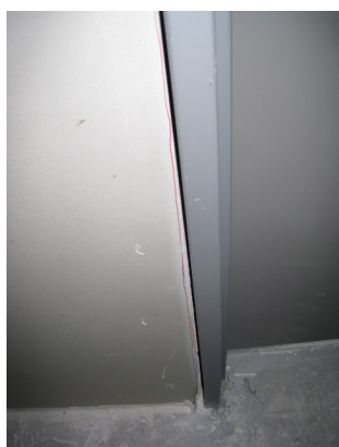
図-8 壁とドアフレームの間に隙間
