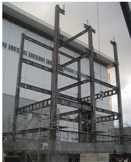
鋼構造架構の建て方
