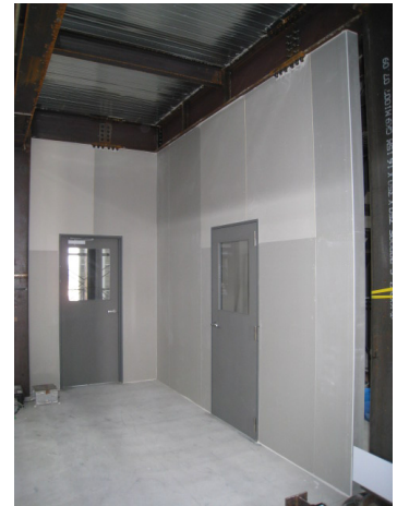
間仕切壁およびドア開口
