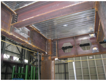
鋼構造柱梁接合部
