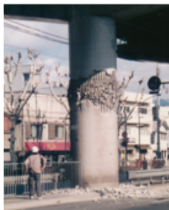
図-2 段落し部せん断破壊の被災状況と実験結果との比較
