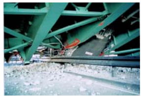
出典：兵庫県南部地震道路橋の被災に関する調査報告書
