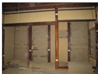
室内被害の様子(移築試験体)
