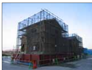
新築中の試験体
