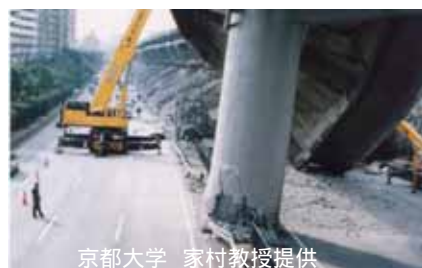
高架橋RC造橋脚の地震倒壊
