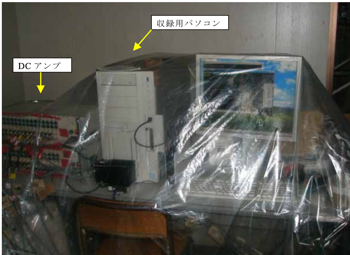
図 16 計測システムの設置状況（建設段階における計測基地）
