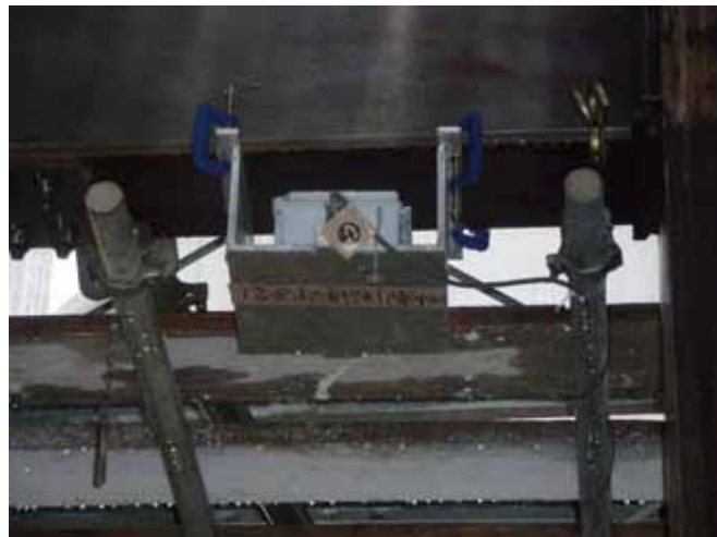
(a) 梁下への設置状況、床スラブ打設前
