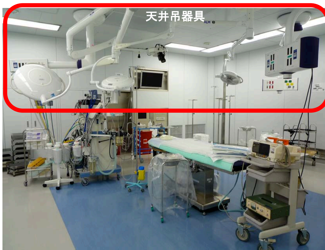
図1 手術室における天井吊機器例
