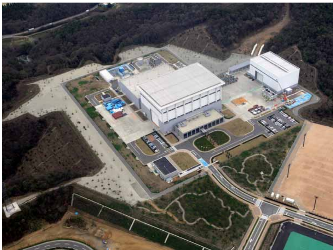
実大三次元震動破壊実験施設（E - ディフェンス）全景
