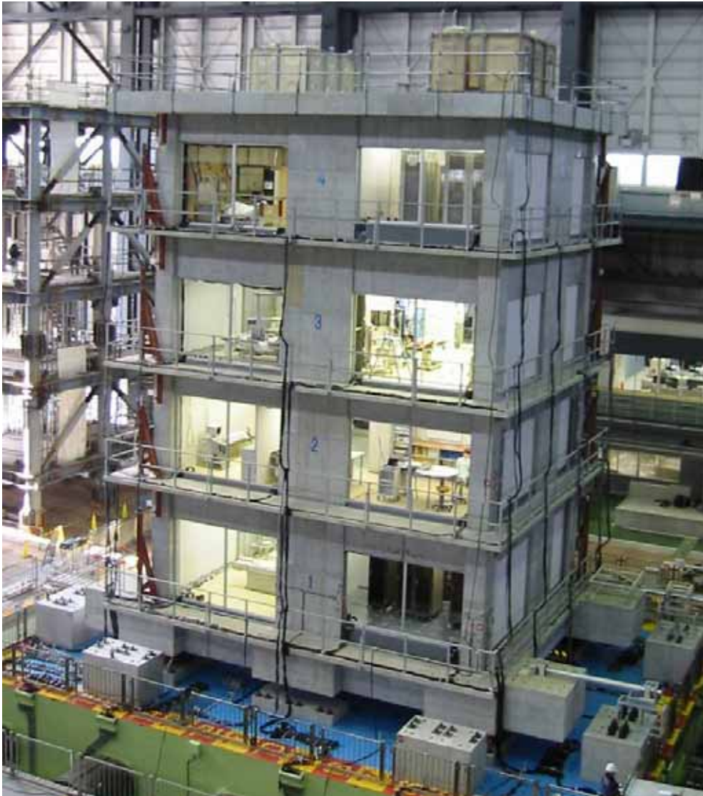
平成 20 年度実験に用いた医療施設を模擬した試験体建物
