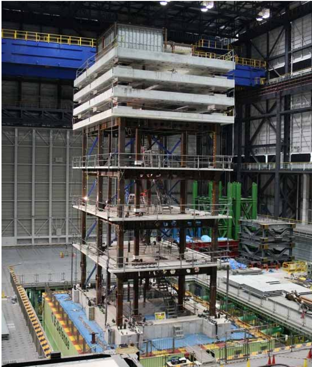
応答低減装置を組み込んだ試験体
