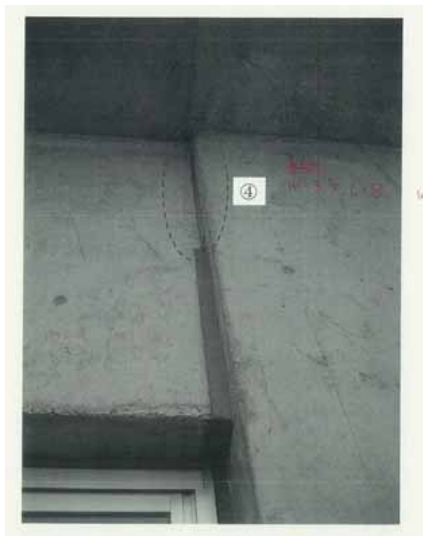
図3 エポキシ樹脂注入 他1カ所
