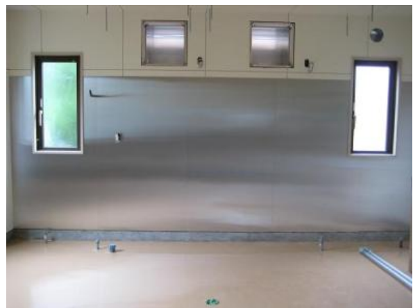
図 2 5 ステンレスパネル(壁面下部)施工例
