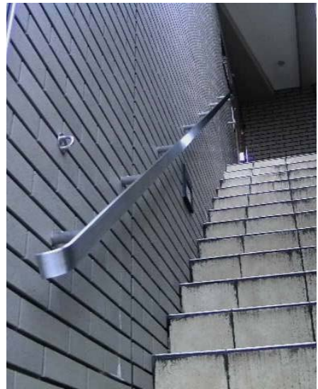
図 2 2 ステンレスフラットバー
