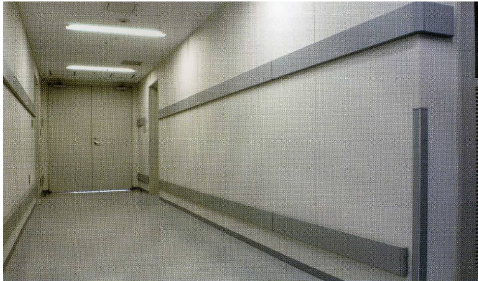
図 2 3 施工例 ガード等
