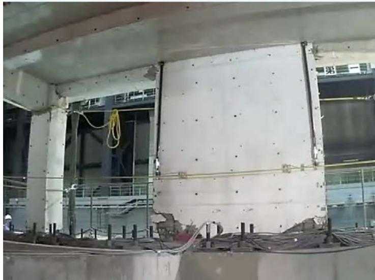
図 10 ネットワークカメラによる構造物の損傷状況（スクリーンショット）
