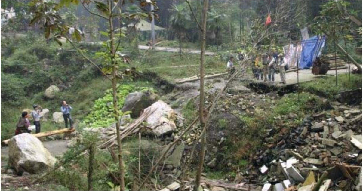
写真1 震源地における地表地震断層の視察（虹口地区）
