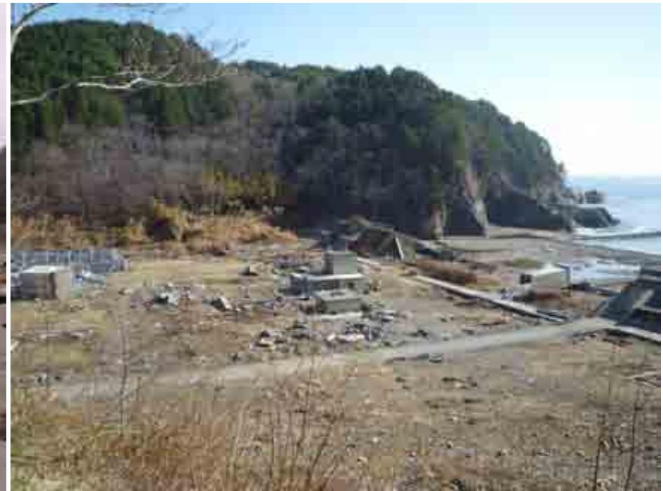
宮古市 女遊戸 堤防が破壊される 津波の高さ 14-26 m
