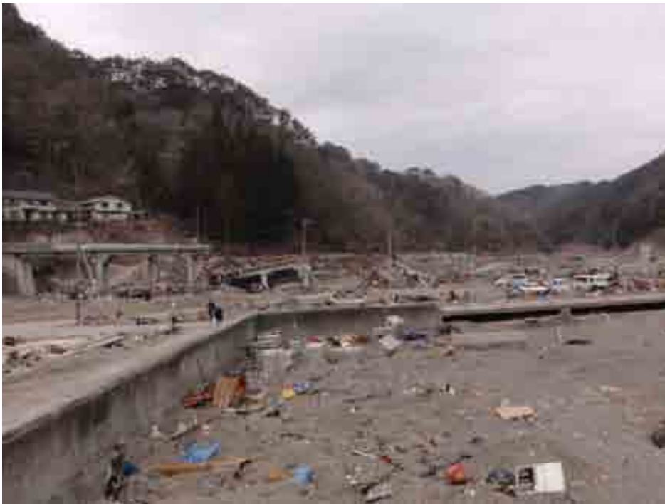
田野畑村 島越 三陸鉄道の橋脚が流出 津波の高さ 20- 22 m
