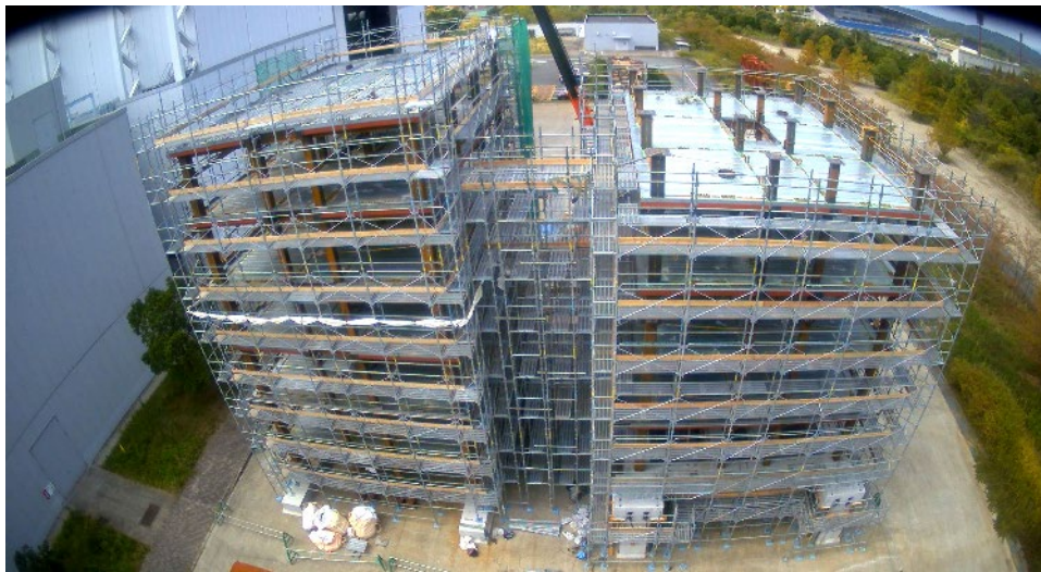
試験体建設状況(11月撮影)
