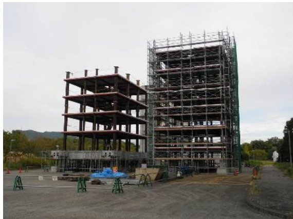
試験体骨組全体
