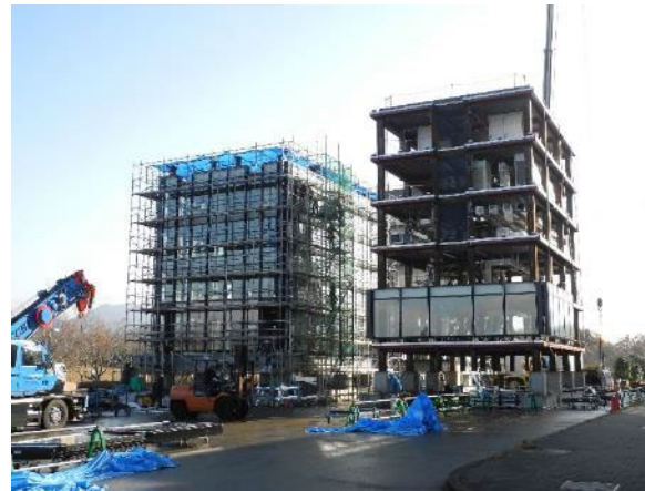
カーテンウォール施工
