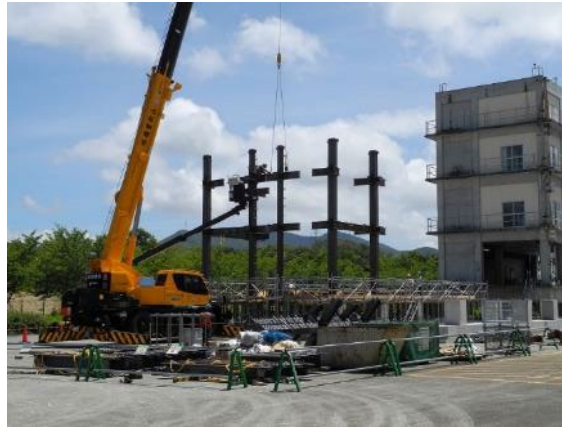
鉄骨の組み立て
