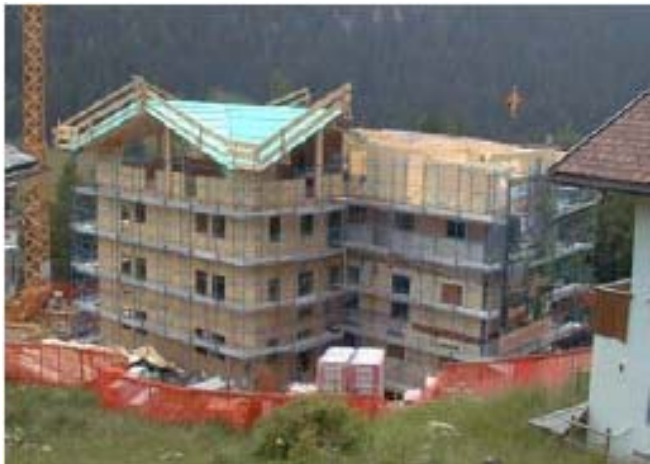
写真3：イタリアでの新壁式木造建物の建設現場
