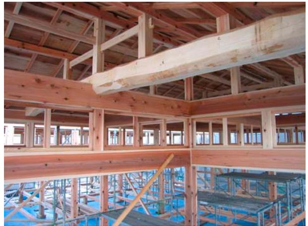
平入り試験体（左側）と妻入り試験体（右側）の建設途中写真
