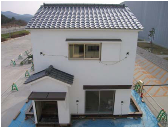
鉄骨架台の上に建つ試験体
