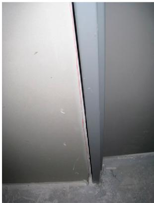
図-5 壁とドアフレームの間に隙間
