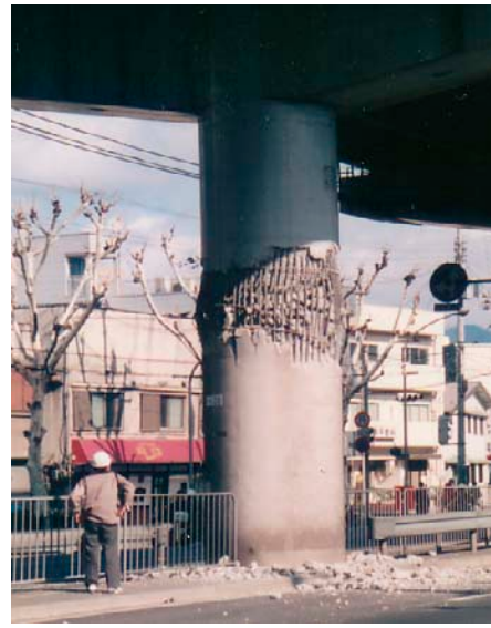
写真-1 兵庫県南部地震によるRC橋脚のせん断破壊
