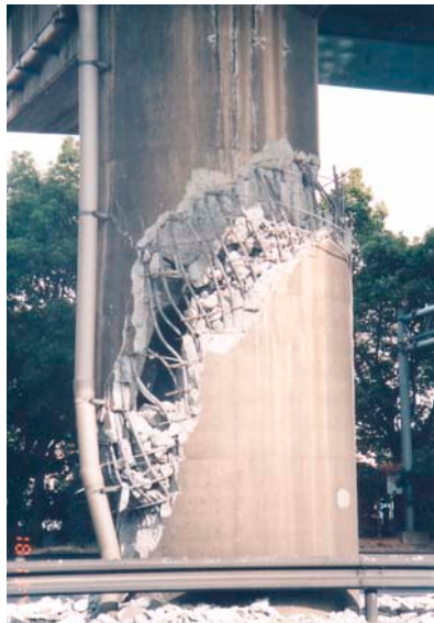
写真-1 兵庫県南部地震によるRC橋脚のせん断破壊
