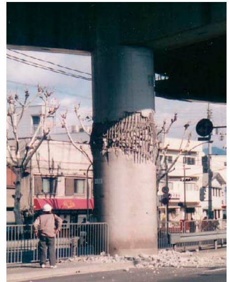
写真 3 兵庫県南部地震による RC 橋脚のせん断破壊 (参考写真)
