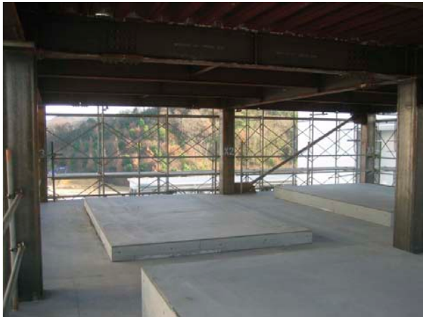
E-ディフェンス施設内で建設中の鉄骨造建物試験体
