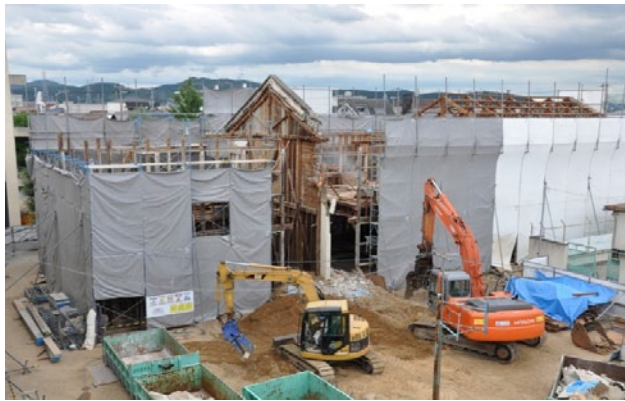
図2. 宝殿中学校で解体中の木造校舎
