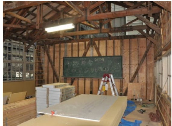
図5. 再構築中の教室内
