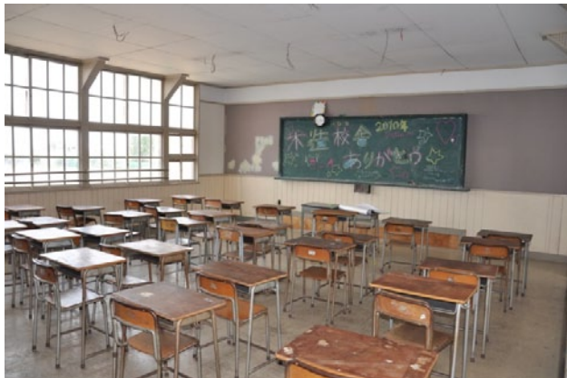
図4. 移築前の教室内
