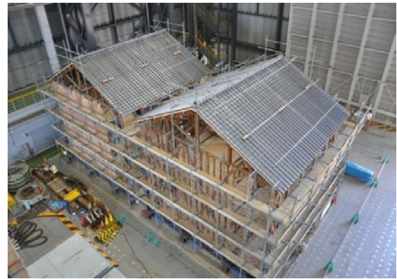
図3. 実験棟内で構築中の試験体2体
