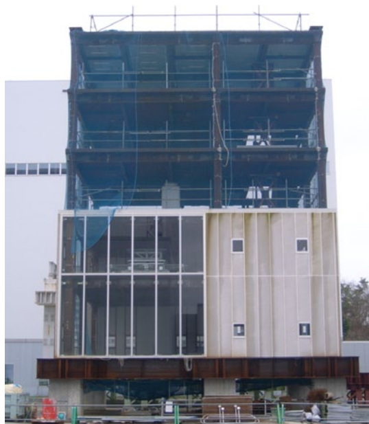
図1 実大鉄骨造5層建物
