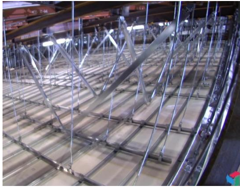
図2 損傷のない2.2G耐震天井(K-NET 仙台波 100%[震度6強]後)
