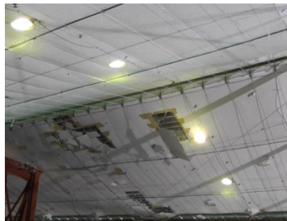
図3 JMA神戸波 100%（震度6強）加振後の被害状況
