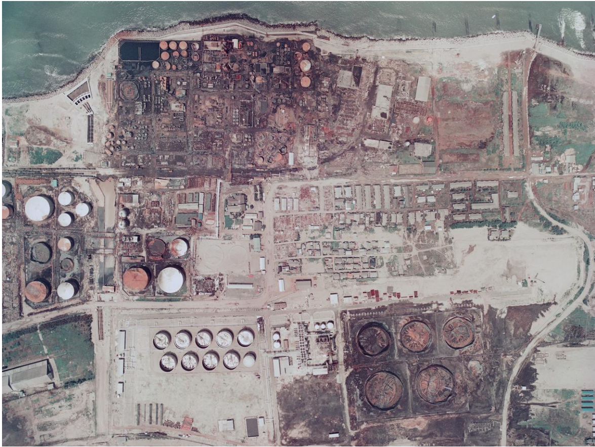
図5: 昭和石油新潟製油所付近の空中写真。約二週間燃え続けた火災が鎮火した後の状況(1964年7月21日、国立防災科学技術センター撮影)
