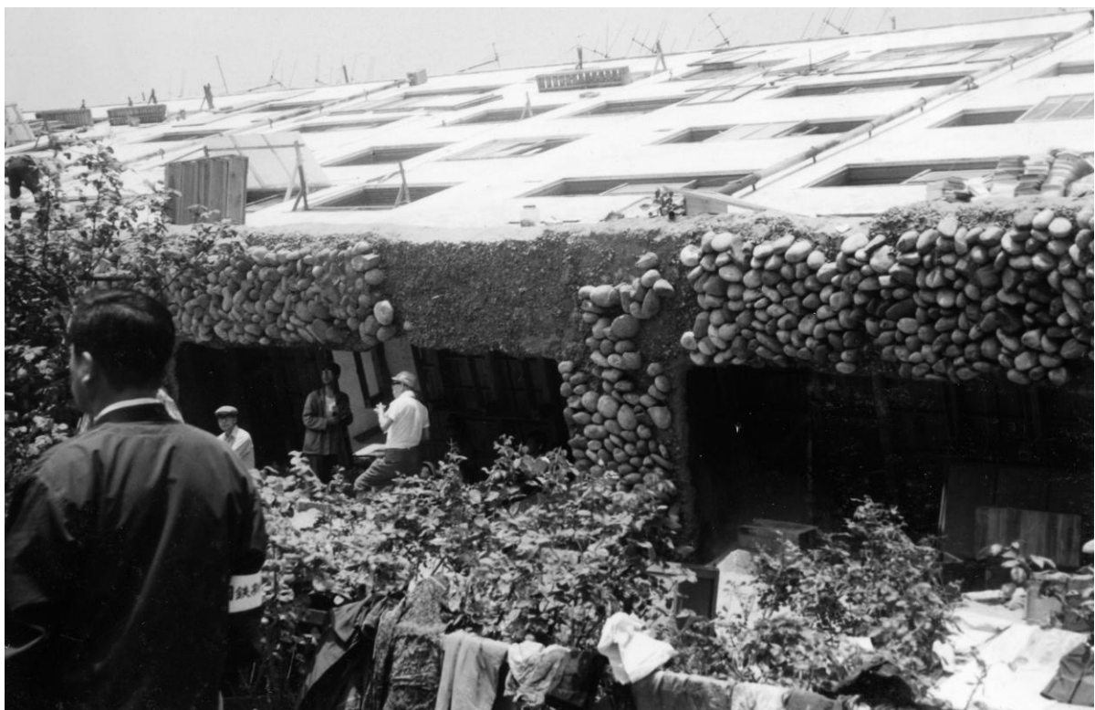
図 4 : 転倒した県営アパート 4 号棟の写真。建物の底部には敷き詰めた丸石が張り付いている（1964 年 6 月 18 日、国立防災科学技術センター撮影）
