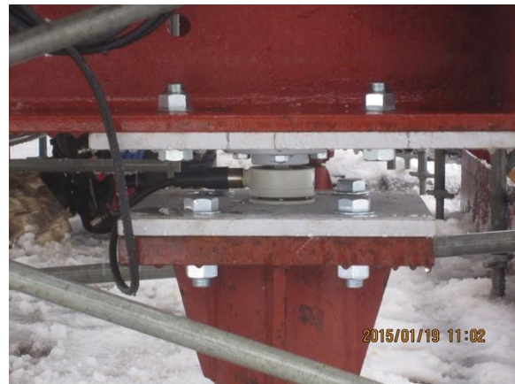
図3 試験体3,4の支柱に取り付けたロードセル
